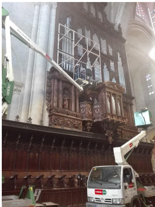
Durant les proves del muntatge i ancoratge dels prototips de bastidors, per comprovar les mides i el bon funcionament. Foto: CRBMC
