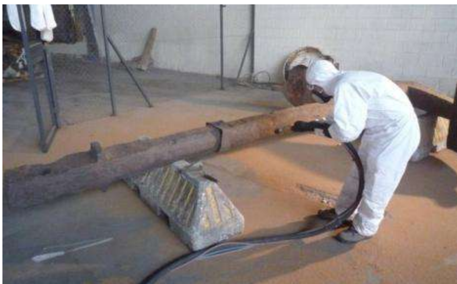
Detall del procés d'eliminació de l'òxid
